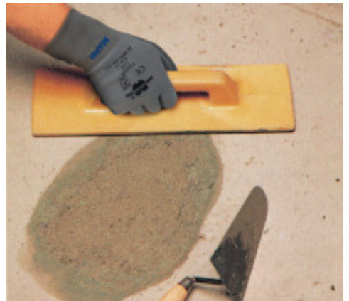
Padlójavítás: besimítás
