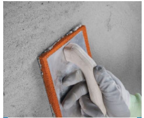
Planitop Rasa & Ripara Zero tömörítése
