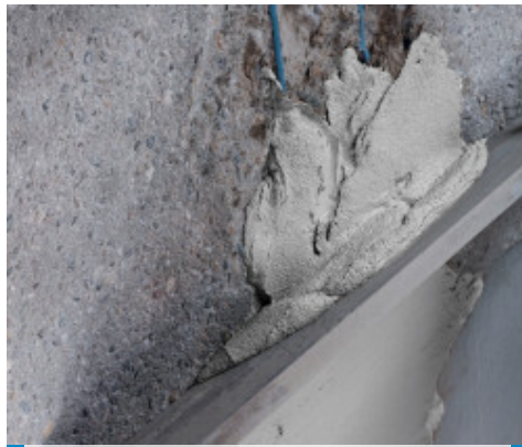
Planitop Rasa & Ripara Zero simítása egyenes lehúzóval
