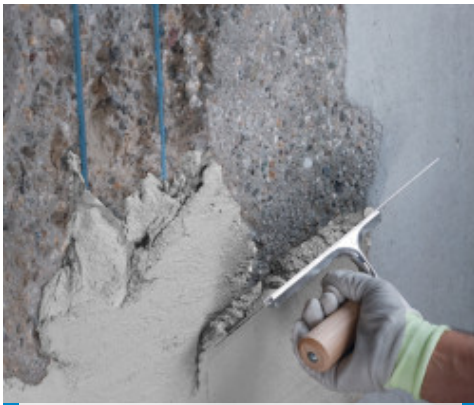
A Planitop Rasa & Ripara Zero felhordása simítóval
