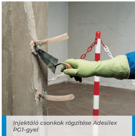
Epojet injektálása megrepedt pillérbe
