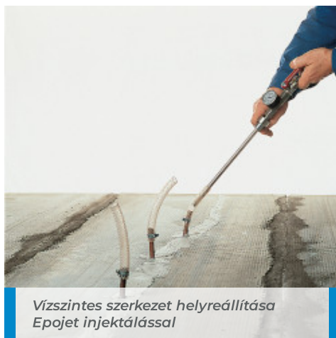
Injektáló csomkok rögzítése Adesilex PG1-gyel
