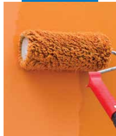
Felületképzés a Silancolor Pittura Plus termék hengerrel történő felhordásával a Mapetherm Flex RP 0,5 mm termékre
