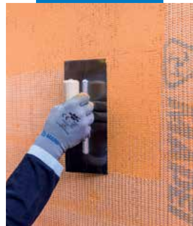
A Mapetherm Net beillesztése a Mapetherm Flex RP nedves rétegre
