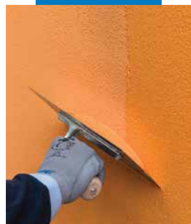
Felületképzés az Elastocolor Tonachino Plus termék glettvassal történő felhordásával a Mapetherm Flex RP 1,5 mm termékre
