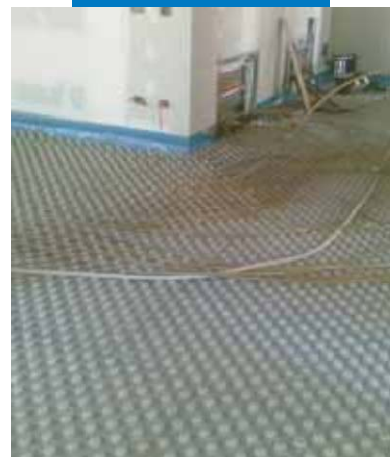
Padlófűtés kialakítása
