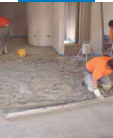
A Mapescreed 704-gyel készült anyag terítése
