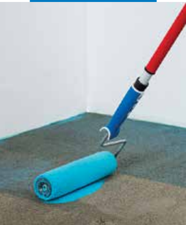
A Mapeproof Primer első rétegének felhordása
