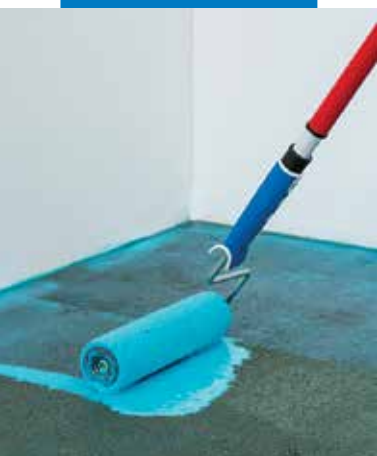
A Mapeproof Primer második rétegének felhordása
