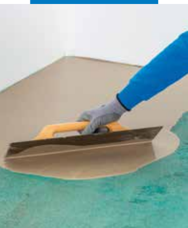
Önterülő aljzatkiegyenlítő felhordása a Mapeproof Primerre
