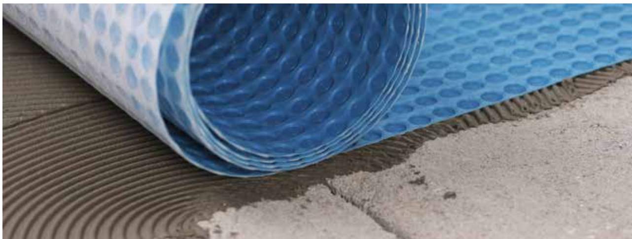
A Mapeguard UM 35 fektetése cementkötésű esztrich dilatációira.
