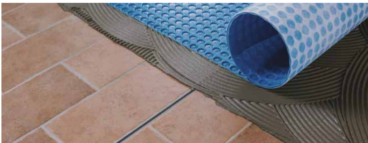
A Mapeguard UM 35 fektetése meglévő kerámia padlóburkolat dilatációjára.
