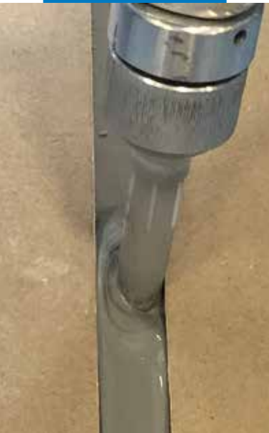
Bedolgozás Mapeflex SPP szivattyúval
