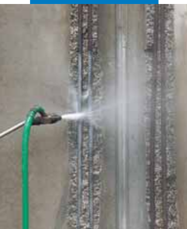
Betonacélok tisztítása
