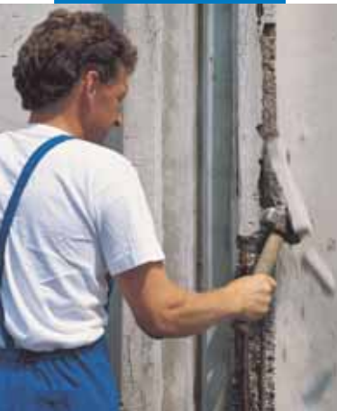
Sérült beton lebontása
