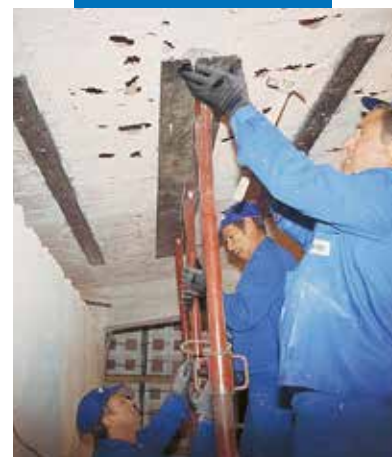
Fémlemezek beépítése lemezrátétes szerkezeti megerősítéshez
