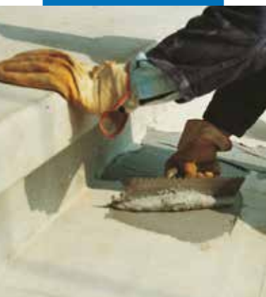
Adesilex PG1 felhordása fogazott glettvassal, előregyártott lépcsőelemek szerkezeti ragasztásához
