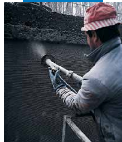
Bertini vízerőmű csatorna - Robbiate (Como) - Olaszország: bedolgozás szórással
