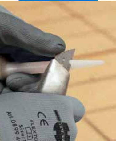
Kinyomóvég levágása a hézag méretének megfelelően
