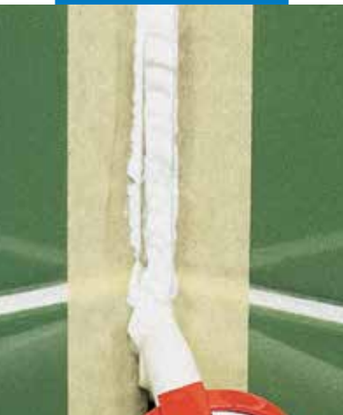
Mapesil AC felhordása
