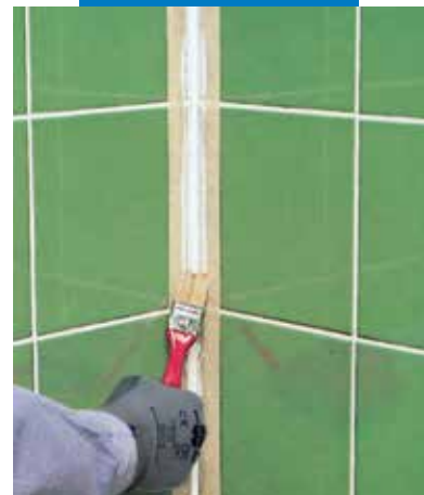
Hézagkitöltés simítása szappanos vízzel és kis ecsettel
