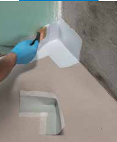
90°-os Mapeband PE 120 sarokelem elhelyezése Mapegum WPS-sel
