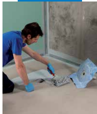
Drain Vertical csatlakoztatása Mapegum WPS-sel
