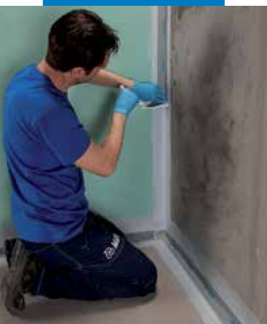
Mapeband PE 120 szalag elhelyezése Mapegum WPS-sel
