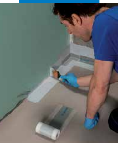
Mapeband PE 120 szalag elhelyezése Mapegum WPS-sel
