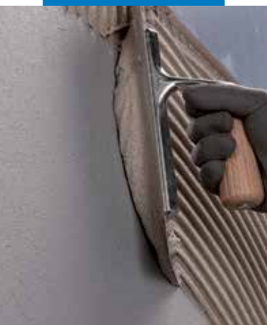
Padlóburkolat elhelyezése Ultramastic III használatával
