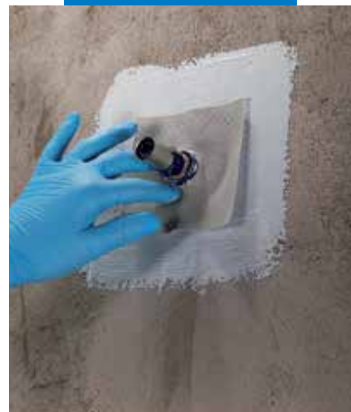
Mapeband PE 120 mandzetta elhelyezése kifolyó körül Mapegum WPS-sel
