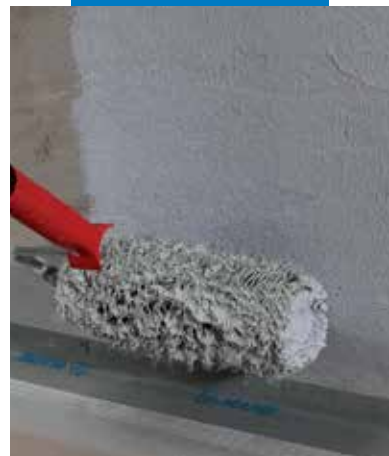
Mapegum WPS felhordása hengerrel
