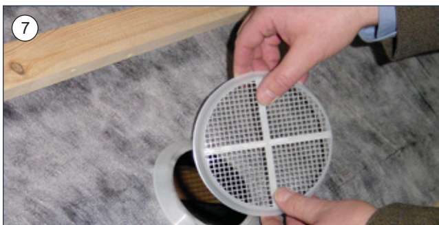
7. Két kézzel tartva helyezük el a rácsos fedőelemet a fóliagyűrűn, a 4 db csatlakozókárom bepattintásával.
