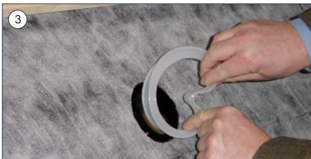
3. A fóliagyűrűt összenyomva be tudjuk helyezni a fólián vágott lyukba.
