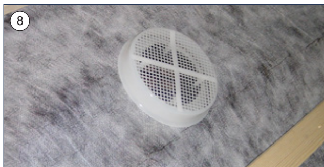
8. A fólia szellőzőgyűrű véglegesen beépített állapotában.
