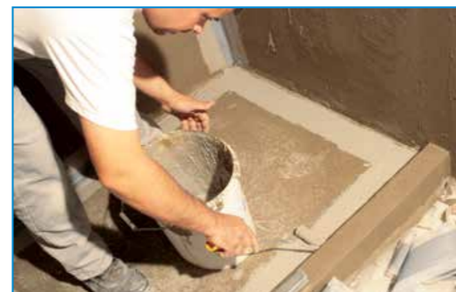
A hajlaterősítő szalag beágyazását az első réteg szigetelés száradása után kezdetjük meg.
