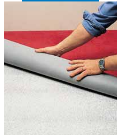
Szőnyegpadló fektetése Rollcollra
