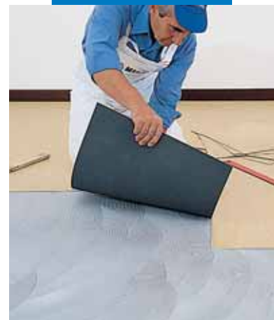
Homogén PVC lapok ragasztása Rollcollal
