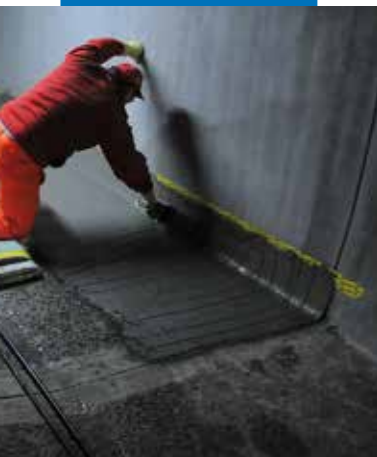
Mapefinish HD felületképzése fém simítóval
