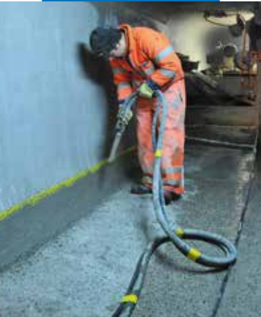
Mapefinish HD bedolgozása gépi szórással
