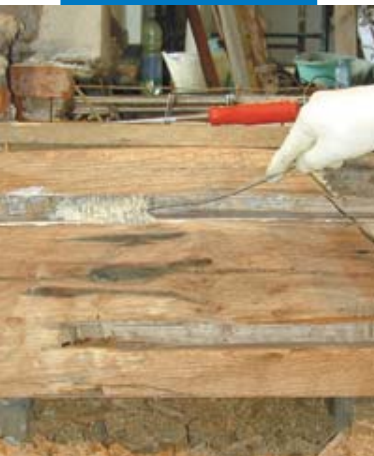
A Mapewood Primer 100 felhordása kis csőkefével
