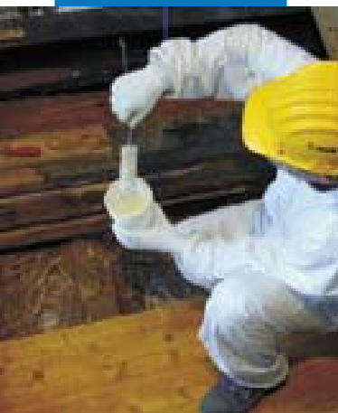
A Mapewood Primer 100 feldolgozási fázisa
