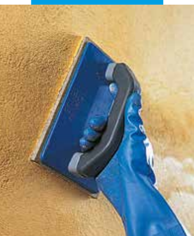
Silexcolor Tonachino simítása szivacsimitóval
