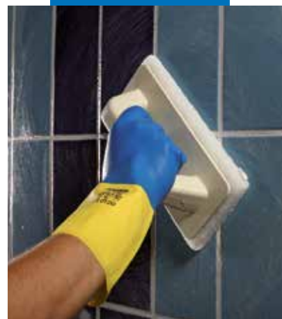
Kerapoxy CQ felület megnedvesítése, és Scotch-Brite® súrolószivacsos emulgeálás
