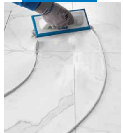
Ultracolor Plus terítése padlón gumisímitóval
