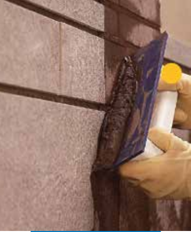
Ultracolor Plus felhordása falra gumilehúzóval
