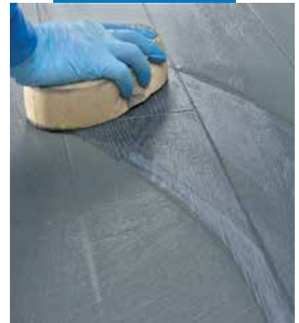
Fugázóhabarcs lemosása és végtisztítása kemény cellulóz szivaccsal
