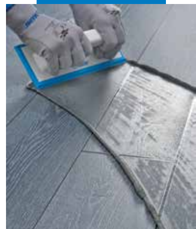
Ultracolor Plus bedolgozása fa hatású greslap padlóburkolatra gumisímitóval
