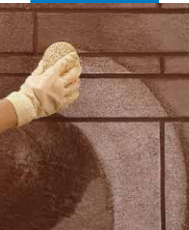
Fugák tisztítása és végtisztítása szivaccsal
