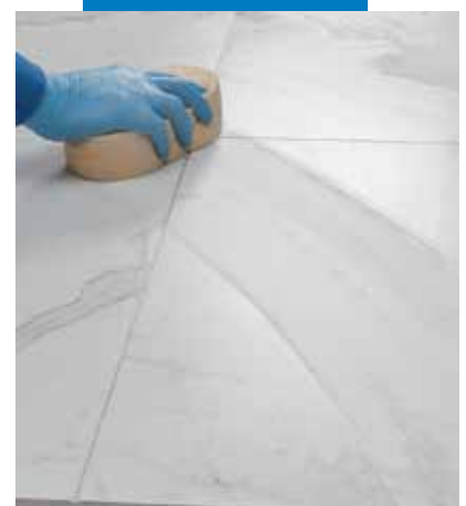
Fugázóhabarcs tisztítása és végtisztítása szivaccsal
