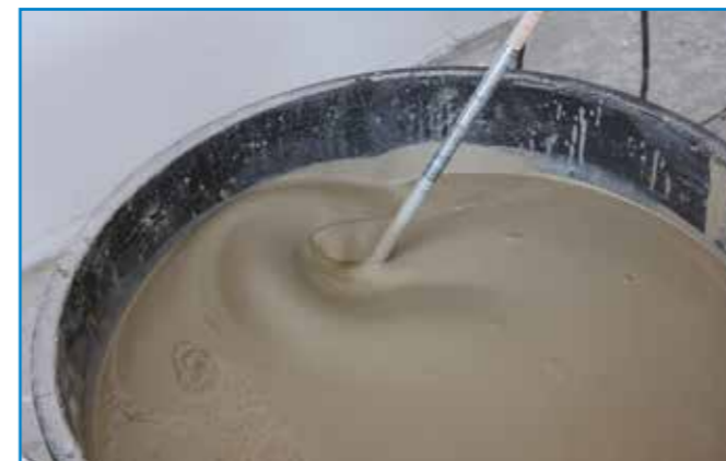
Az aljzatkiegyenlítőt a hozzá adott vízzel keverjük össze lassú fordulatszámon működtetett keverőgéppel.
