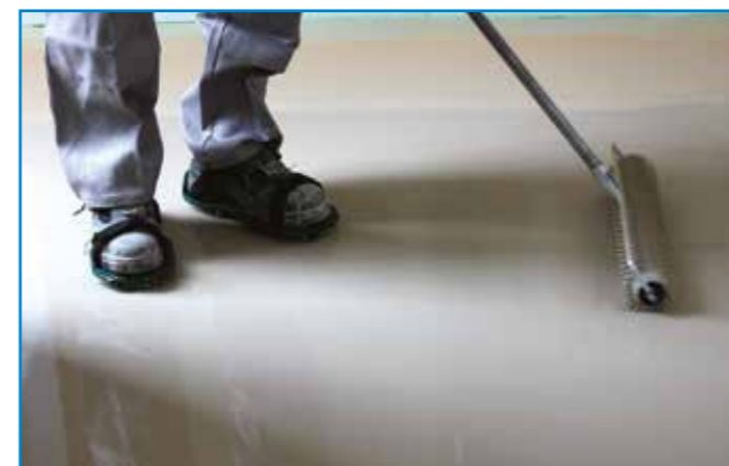
A rétegvastagságnak megfelelő tuskéhengert használjunk a kilevegőztetésre.
