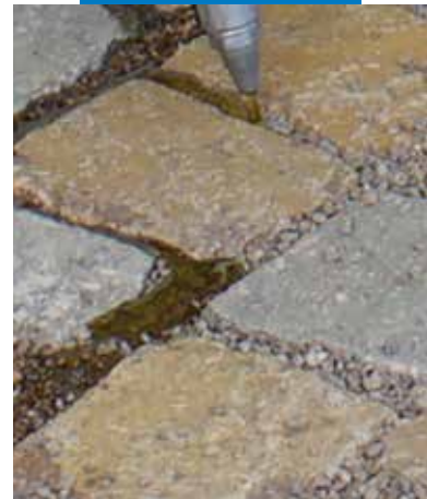
Mapestone Joint bedolgozása
