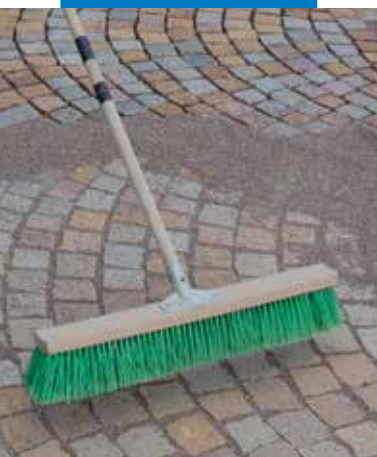
Fugahézagok kitöltése finom kavicsal
