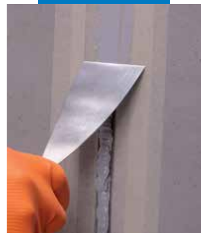
Mapeflex PU40 átsimítása
