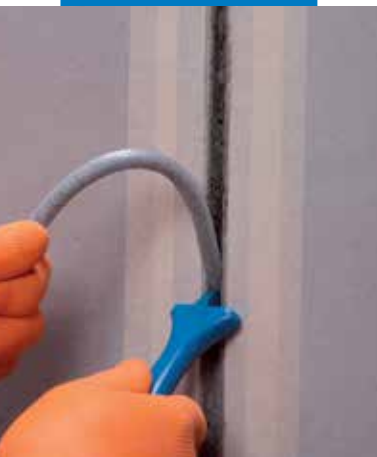
Mapefoam hézagba helyezése
