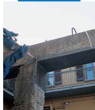
Gerenda javítása Epojet injektálással
