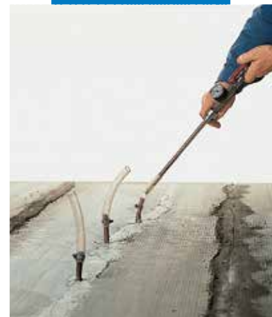
Vízszintes szerkezet helyreállítása Epojet injektálással
