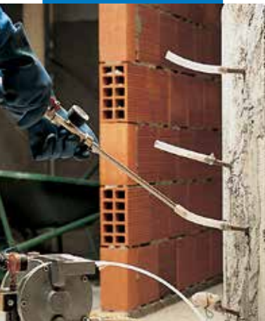
Epojet injektálása megrepedt pillérbe
