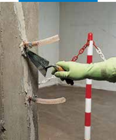
Injektáló csomok rögzítése Adesilex PG1-gyel
