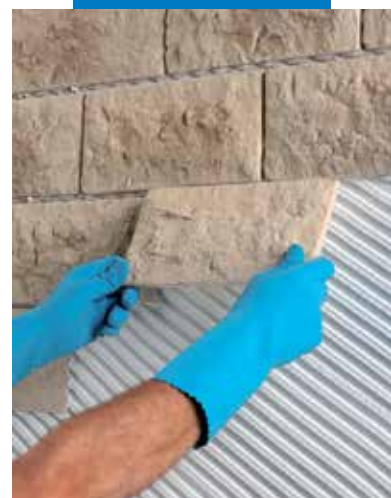
Példa egy könnyűsúlyú cementes díszburkolati elem fektetésére kültéren
