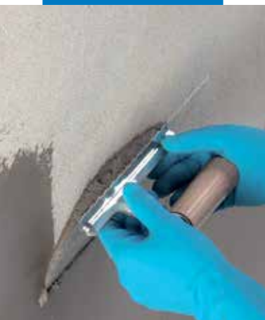
Szürke színű Fix & Grout Brick kontakréteg felhordása az aljzatra
