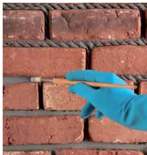
Fugahézag simítása nedves ecsettel
