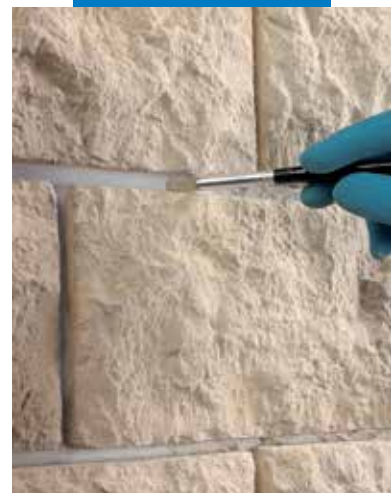
Fugakép kialakítása nedves ecsettel
