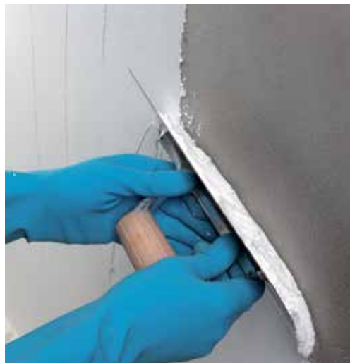
Ragasztó kontaktréteg felhordása az aljzatra
