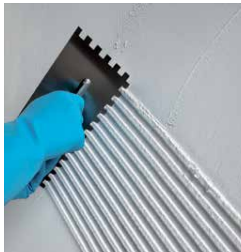
Fehér színű Fix & Grout Brick átlós irányú felhordása 10-es fogazott simítóval
