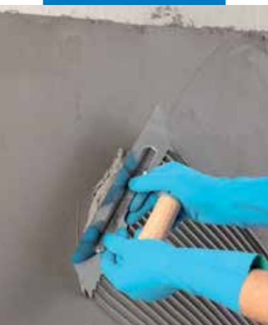
Szürke színű Fix & Grout Brick átlós irányú felhordása fogazott simítóval
