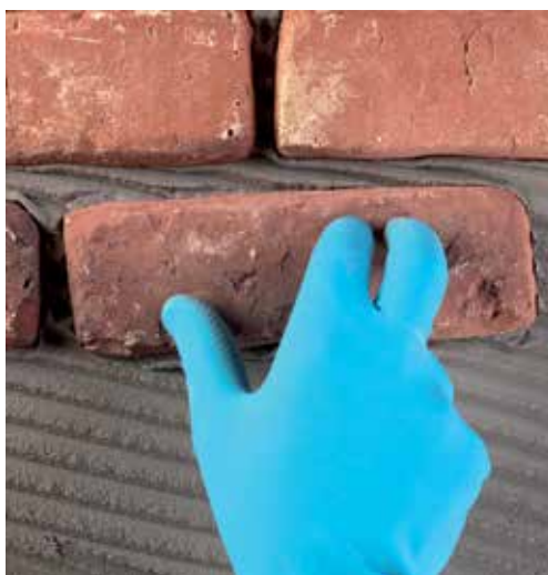
A burkolóelemek felhelyezése biztosítja a nedvesítést és a fugahézagok kitöltését
