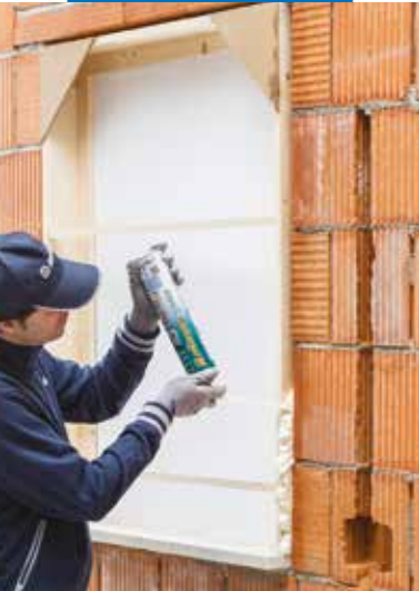
Rések kitöltése egy ablakkeret és a fal között
