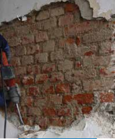
A meglévő vakolat eltávolítása
