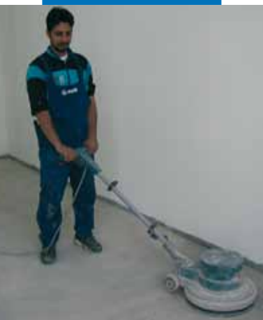
Csiszolás Ultraplan Eco bedolgozása előtt - Mirabello óvoda - Cantù (Como) - Olaszország
