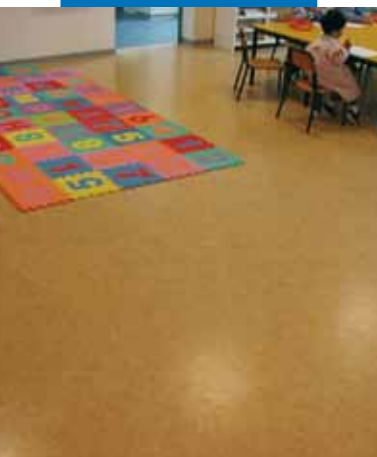
Linóleum burkolat Ultraplan Eco-val előzetesen kiegyenlített esztrichen - Mirabello óvoda - Cantù (Como) - Olaszország
