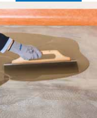
Ultraplan Fast Track bedolgozása fém simítóval
