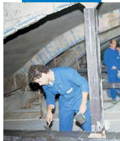
Mapegrout Colabile öntése fém szaluzatba
