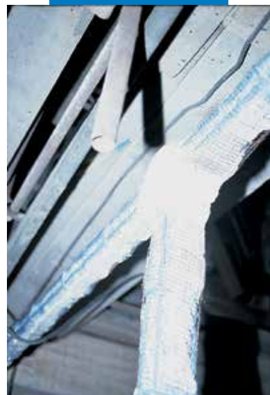
Károsodott betonszerkezet
