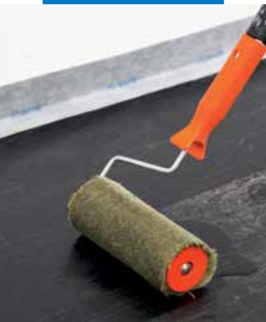
Aquaflex Roof Premium felhordása régi bitumenes lemezes felületre
