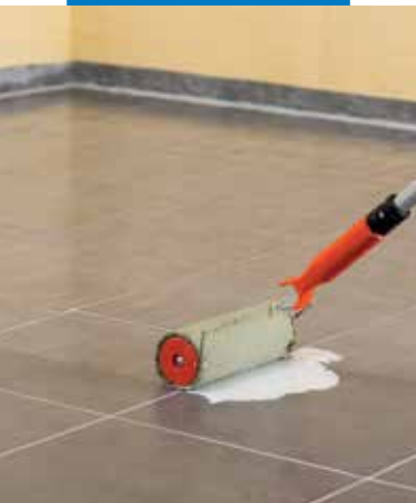
Mapecoat I 600 W alkalmazása megfelelően előkezelt kerámialapokra
