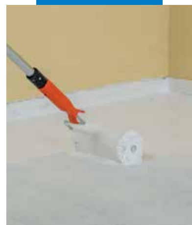
Második réteg Aquaflex Roof Premium alkalmazása
