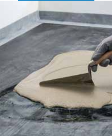
Mélyedés kitöltése MapeSlope-pal előtte Primer P3-mal alapozva
