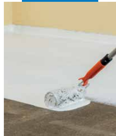
Első réteg Aquaflex Roof Premium alkalmazása esztrichbetonon
