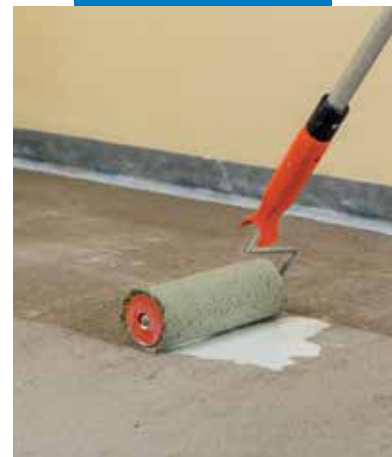
Cementes felület alapozása Mapecoat I 600 W-vel
