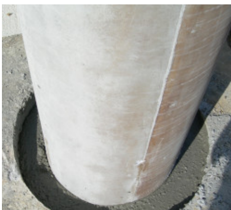
Előregyártott pillér rögzítése
