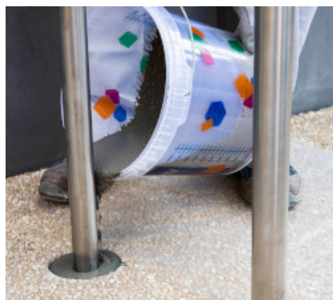
Utcai bútor rögzítése
