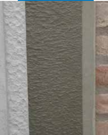
PoroMap Előfröcskölő bedolgozása Mapelastíc Foundation-ra, antikondenzációs rendszerben
