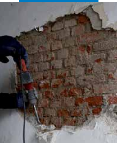
Károsodott vakolat eltávolítása
