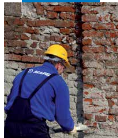
PoroMap Előfröcskölő bedolgozása vakológéppel
