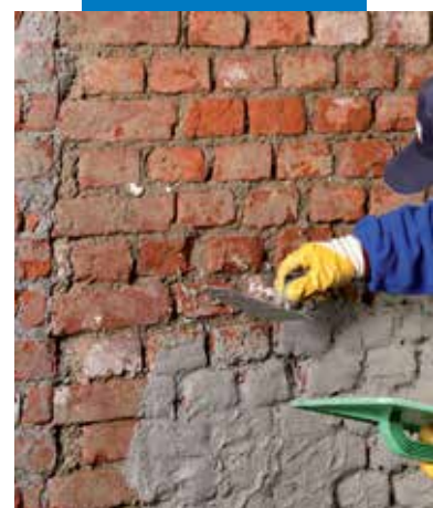
PoroMap Előfröcskölő bedolgozása simítóval
