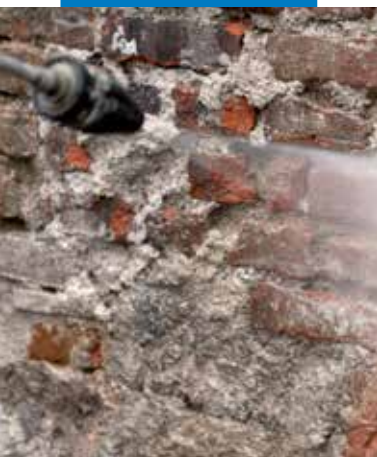
Falazat magasnyomású vízzel mosása
