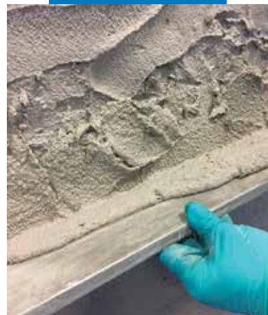
A PoroMap Szárítóvakolat lehúása egyenes simítóval
