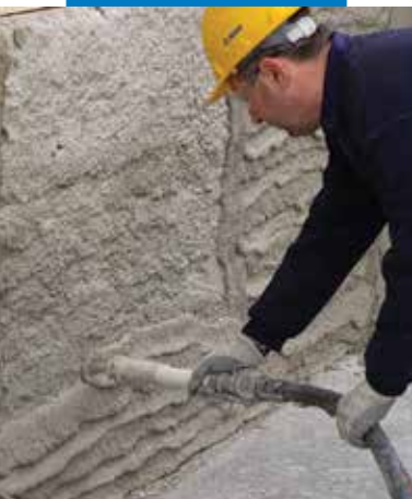
A PoroMap Szárítóvakolat felhordása vakológéppel
