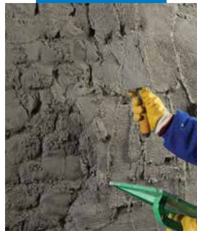
A PoroMap Szárítóvakolat felhordása simítóval
