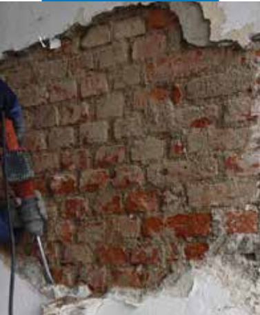
A meglévő vakolat eltávolítása
