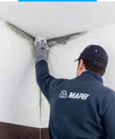
Falak tisztítása Silancolor Cleaner Plus-szal
