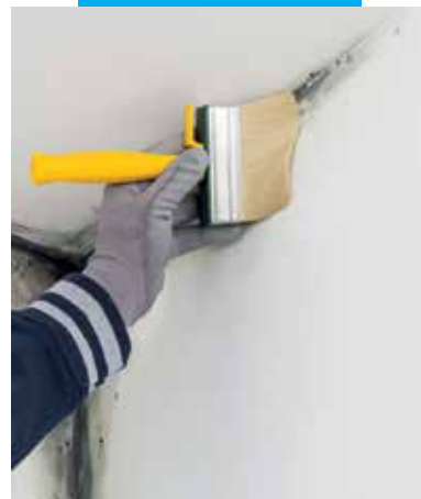
Az alapozó felhordása (a Silancolor Primer Plus használata előnyösebb)
