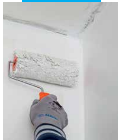
Dursilite Plus felhordása hengerrel
