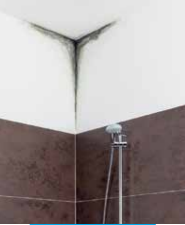
A penész látható jelei a felületen
