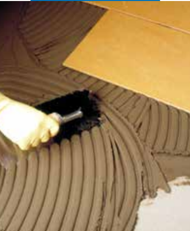
Elastorapid feldolgozása fogazott simítóval cementkötésű esztrichre
