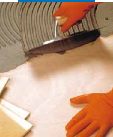
Porcelán burkolólapok ragasztása Elastorapid-dal rétegelt lemezre
