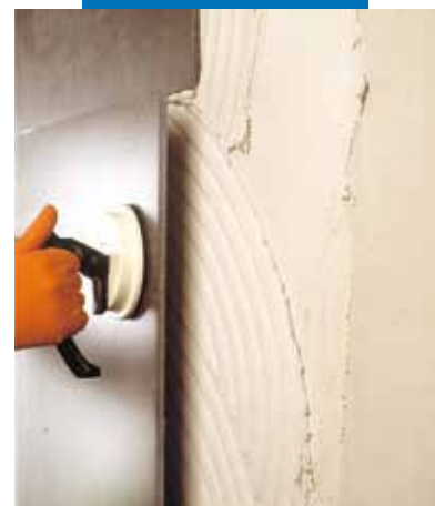
Nagyméretű kőporcelán burkolólapok ragasztása Elastorapid- dal beton homlokzatra
