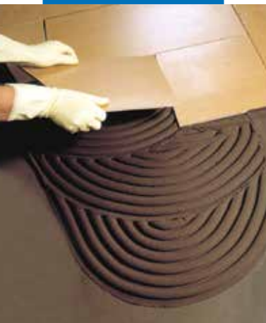
Porcelán burkolólapok fektetése Mapelastical-kal vízszigetelt esztrichre
