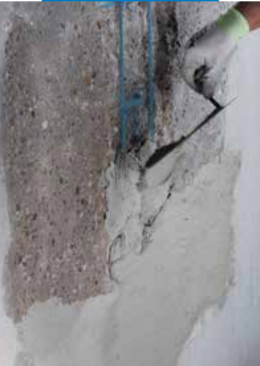
A Planitop Rasa & Ripara felvitele vakolókanállal
