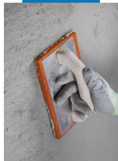
A Planitop Rasa & Ripara besimítása
