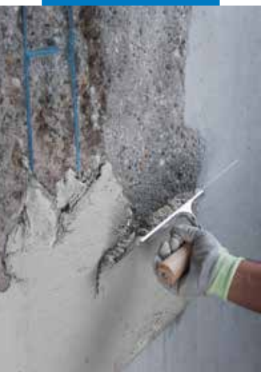
A Planitop Rasa & Ripara felvitele simítóval
