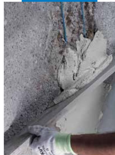
A Planitop Rasa & Ripara lehúzásá kartecsnivel
