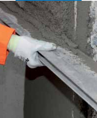
A Mapegrout 430 simítása sima simítóval
