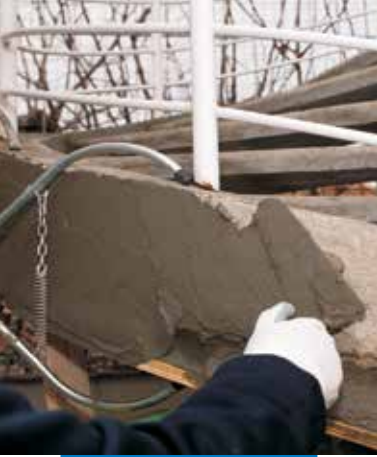
A Mapegrout 430 bedolgozása simítóval
