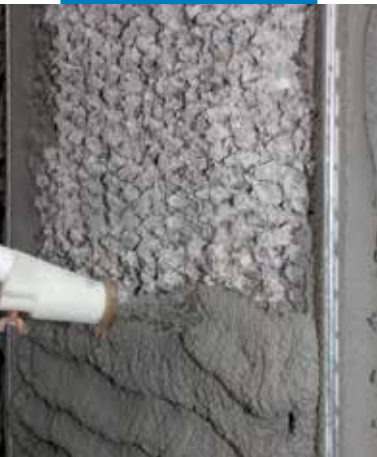
A Mapegrout 430 bedolgozása szórással
