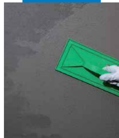
A Mapegrout 430 besimítása
